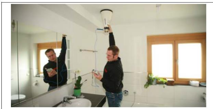
Rys. Pomiary instalacji
