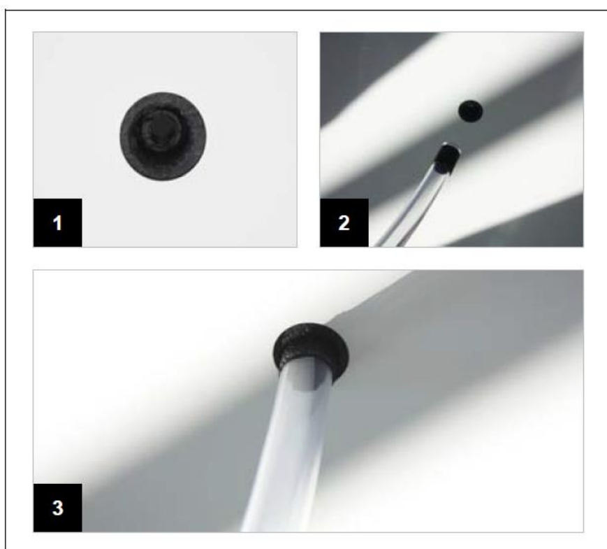
Rys. 4.3 Sposób instalacji węża do odprowadzania skroplin
